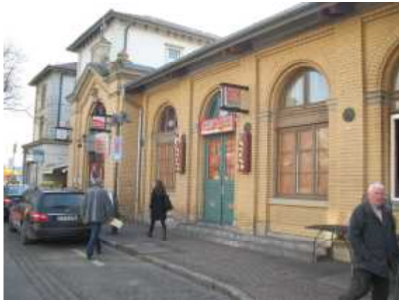
Foto 61: Spielhalle im Bahnhofsgebäude
