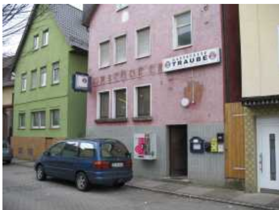
Foto 75: Warthäuser Straße 6 (Wettbüro)
