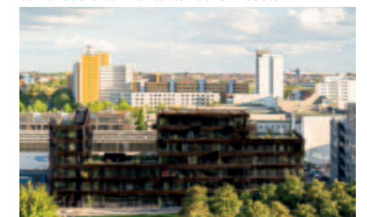
FRIZZ23 /// Architektonischer Baustein
