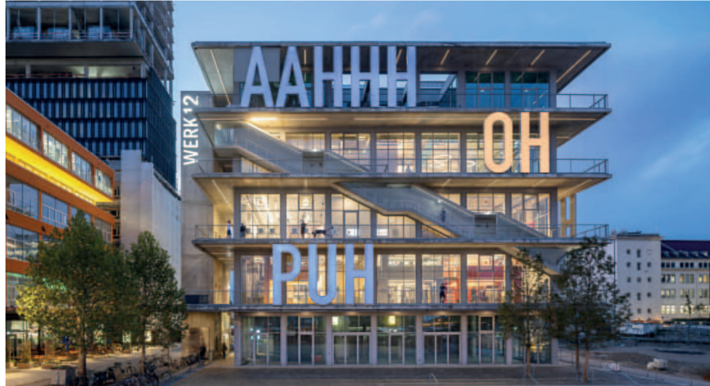
Gebäude Werk 12: Büros, Gastronomie und Freizeitnutzungen Quelle: © Ossip van Duivenbode (MVRDV)
