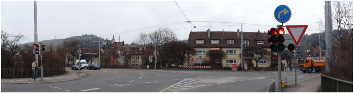
Defizite in der Ortseingangssituation im Kreuzungsbereich Otto-Hirsch-Brücken/Imweg
