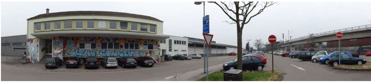
Vorfeld S-Bahn-Haltepunkt Zuffenhausen
