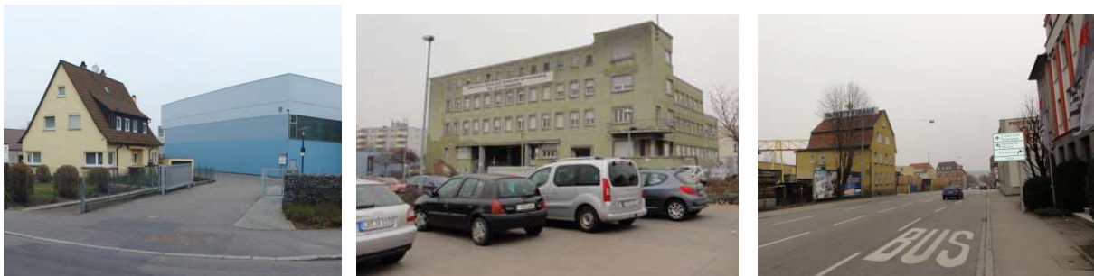
Gemengelagen, gewerblicher Leerstand, Ortseingangssituation Schwieberdinger Straße
