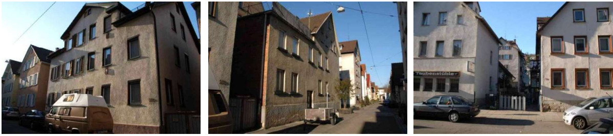
Modernisierungsrückstände bei Gebäuden mit überwiegender Wohnfunktion, u.a. Untere Straße
