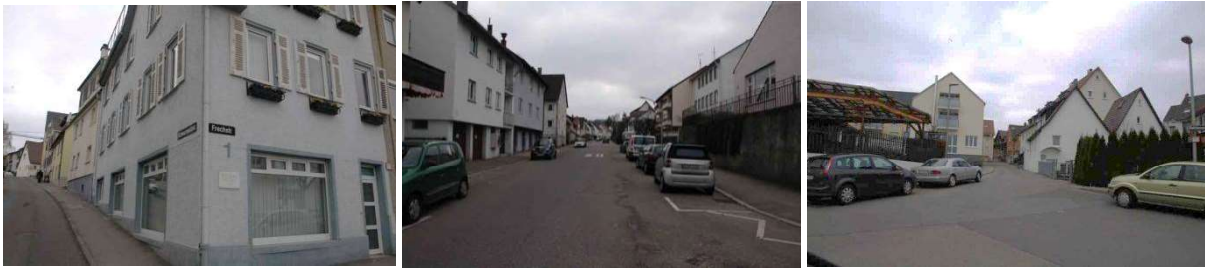
Modernisierungsbedarf und funktionale wie gestalterische Mängel im Straßenraum Ortslage Kaltental
