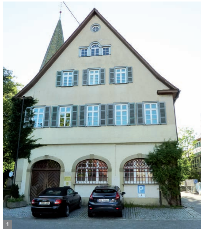
1 Alte Räume - neu genutzt Die Abteilung als Bauherr
