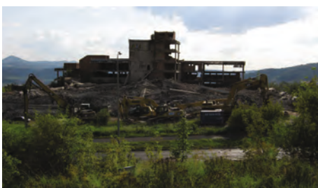
Abb. 32: Gebäudeabriss auf einer Brachfläche
