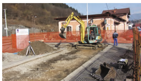
Abb. 25: Informationsstand in der Bauphase
