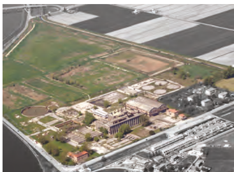
Abb. 26: Luftansicht der ehemaligen Zuckerfabrik
