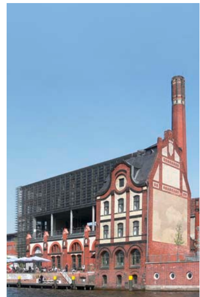
Radialsystem V, Berlin-Friedrichshain Gerhard Spangenberg Architekt, 2006 Foto: Andreas Praefcke
