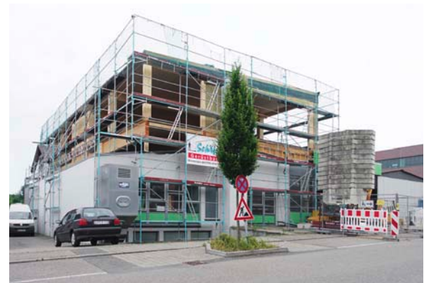
Aufstockung Werkstatthalle Fenster Mack, Korb Architekt Roland Schäfer, 2019
