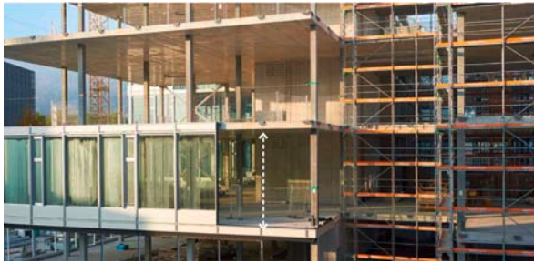
Funktionale Industriefassade, Nutzlast 1000 kg/m 2 , keine Innenwände, minimaler Grundausbau, doppelt hohe Geschosse
