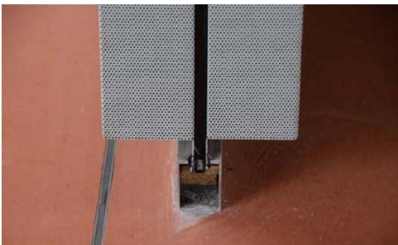
Abb. 2: Bodenanschluss der Glas-Akustikwand
